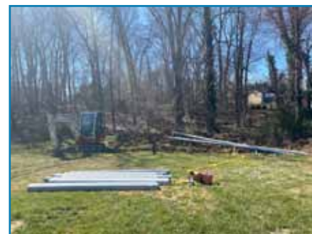
Ya iniciaron los trabajos en la parte de atrás del edificio
